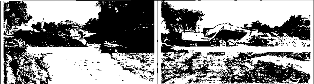
Fotos 09 e 10: Canal 01 lado direito, escavação de solo mole e regularização do canal.
